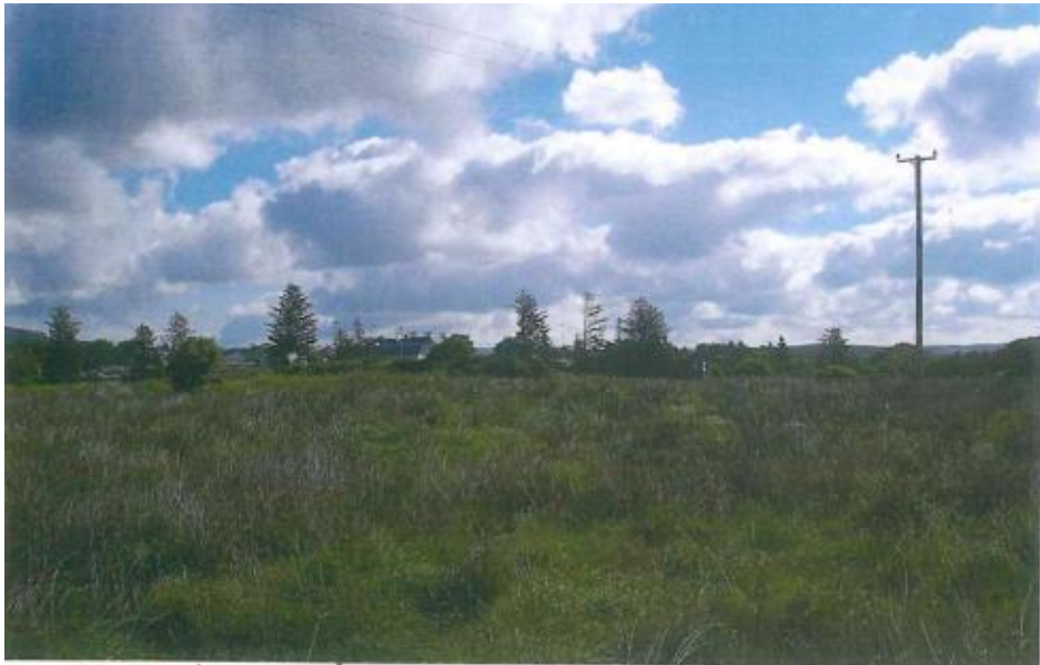
Site A - O/H Cables
